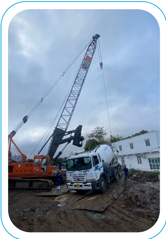
CÔNG TRÌNH : CẦU VƯỢT MƯƠng ĐIỂM - TUYẾN TRÁNH LONG XUYÊN
